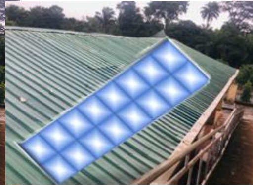
Nebengebäude (PV Dachfläche)
